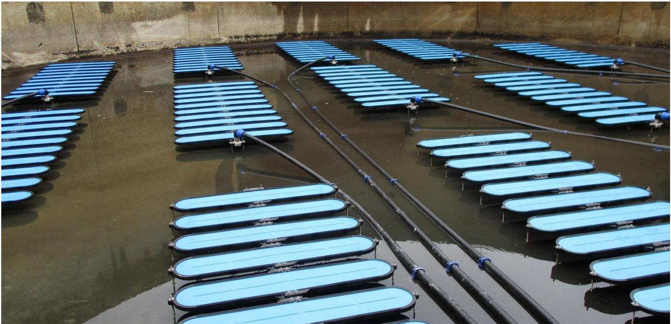
Es wird empfohlen, die Rohrleitungen beginnend am Anschlusspunkt an der Luftversorgungsleitung zur Position des Belüftungsmoduls am Beckenboden zu verlegen.
